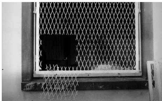
Fenêtre vue de l'extérieur avec le rectangle découpé dans la grille.
