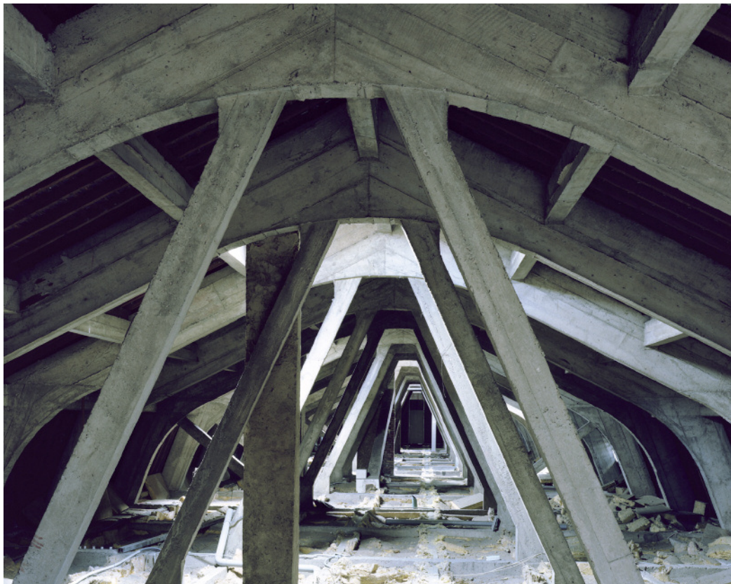
Charpente. Palais Saint-Georges
