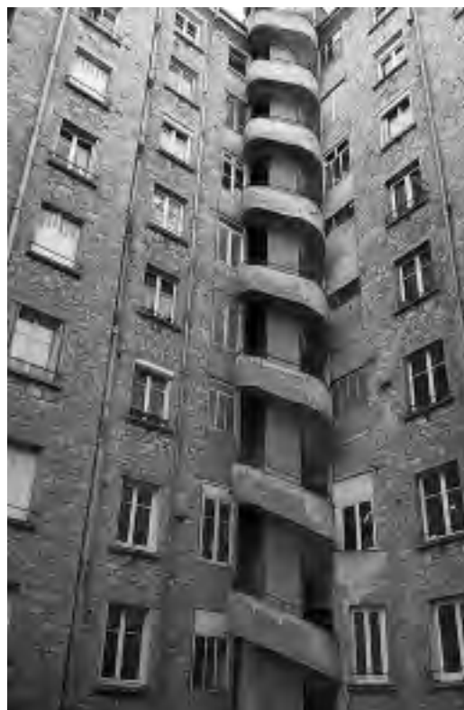
À l'arrière de l'immeuble, un élégant escalier extérieur témoignant d'une belle maîtrise du béton armé.
